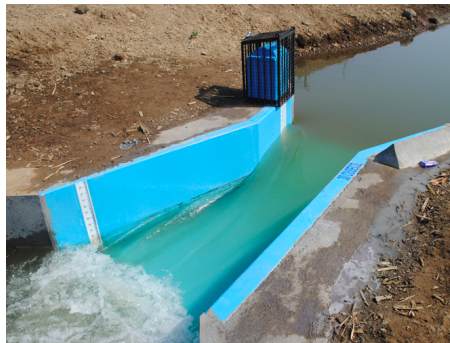
Parshall flume ou débitmètre Venturi
