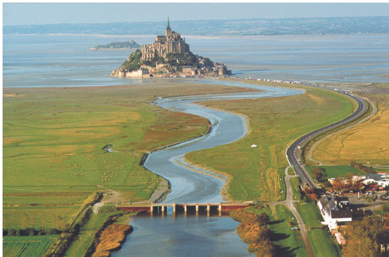
Barrage du Couesnon
