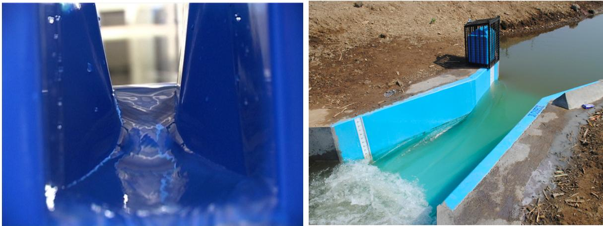
FIGURE 6 – Exemple de venturi ou "Parshall flume"
